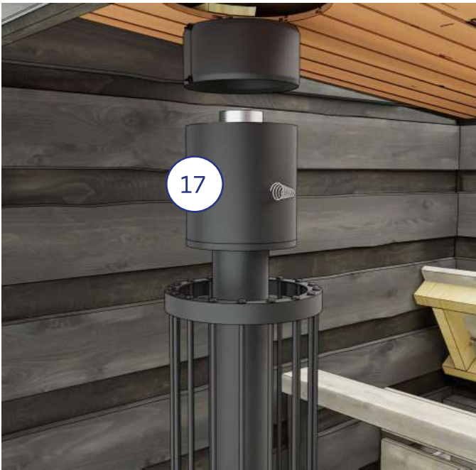
9. Asettele savupeltijakso ( 17 ) savuputken ( 18 B.) päähän.
